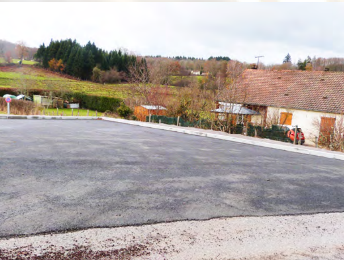
↑ Bitumage de l'aire de retournement du chemin de la Faurie
