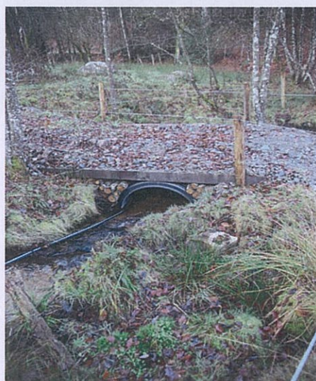
Exemple de passage demi-buse PEHD
