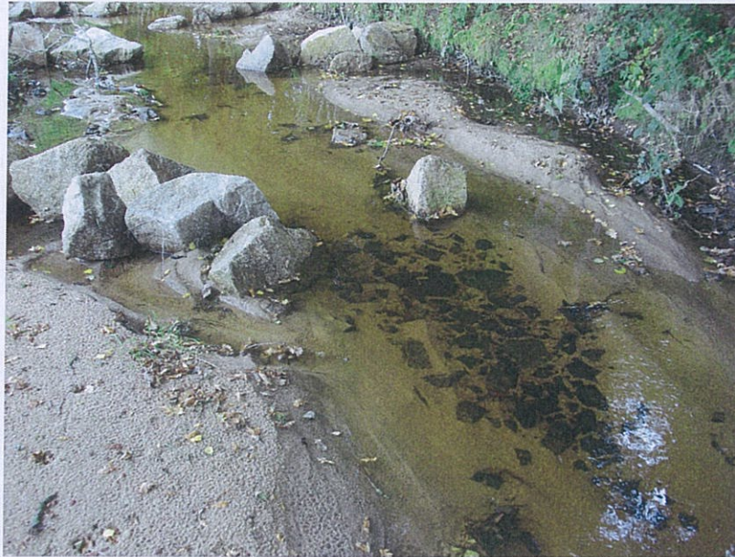
Pose de blocs pour le décolmatage du cours d'eau
