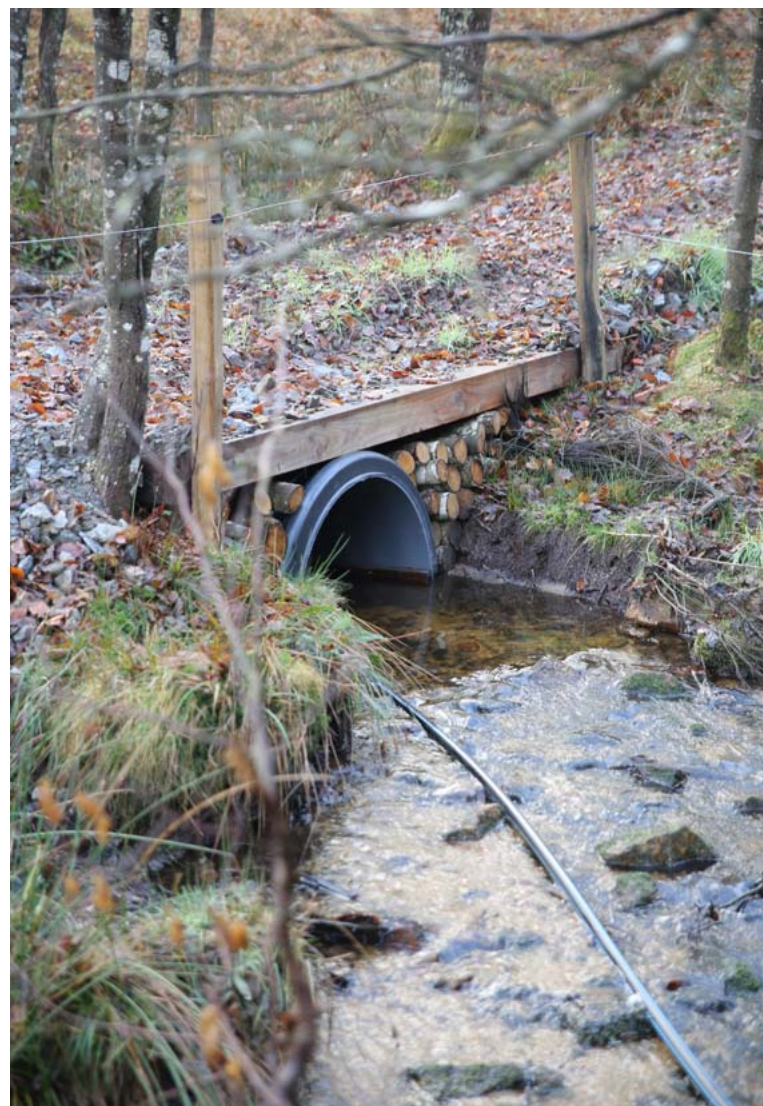
▲ passage construit avec demi buses PEHD* ▼
