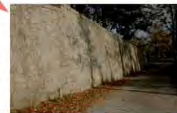
Cyclopéen : appareillage de gros blocs irréguliers encastrés les uns dans les autres à joints vifs
