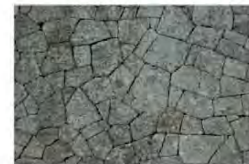
Cyclopéen : appareillage de gros blocs irréguliers encastrés les uns dans les autres à joints vifs
